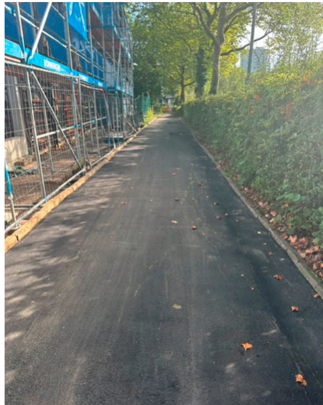
Westfalendamm: Auf einer Länge von 300 Metern wurde das alte Pflaster durch glatten Feinasphalt ersetzt.
