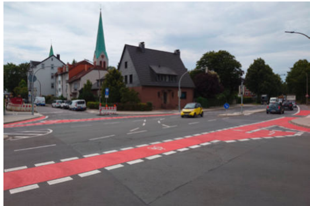
Burgring/Siegenstraße: Witterungsbedingt konnte die Markierung im Jahr 2023 nicht mehr aufgebracht werden. Jetzt leuchten die Furten rot.
