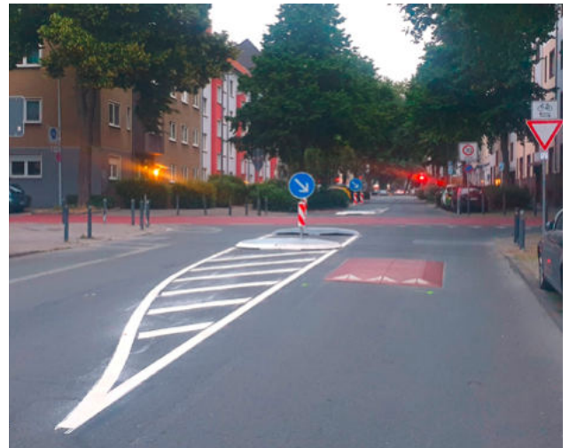
Neuer Graben/Große Heimstraße: Für den RS1 wurde die Lichtsignalanlage an der Kreuzung Neuer Graben/Große Heimstraße abgebaut. Die neuen Querungshilfen verbessern den Fußverkehr und entschleunigen den Verkehr aus der Straße Neuer Graben, bevor er auf den bevorrechtigten RS1 trifft.
