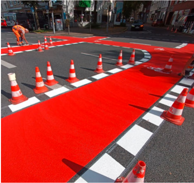
Hohe Straße/Dudenstraße/Gutenbergstraße: Auf einer Fahrbahn wird markiert, auf der anderen fließt bereits der Verkehr.
