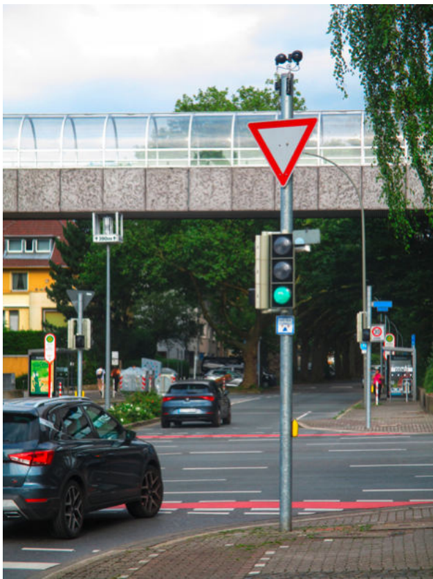
Ruhrallee/Markgrafenstraße: Die Lichtsignalanlage wurde in östlicher und westlicher Fahrtrichtung mit Detektoren ausgestattet, die den Radverkehr frühzeitig erfassen.
