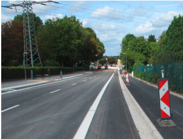
Planetenfeldstraße: Die Parkbuchten auf der östlichen Seite wurden zugunsten des Fuß- und Radverkehrs in Geh- und Radwege umgewandelt.
