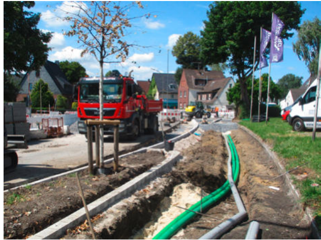
Burgring: Der Knotenpunkt mit der Siegenstraße wurde umfassend neugestaltet, um Platz für alle Verkehrsteilnehmenden zu schaffen.
