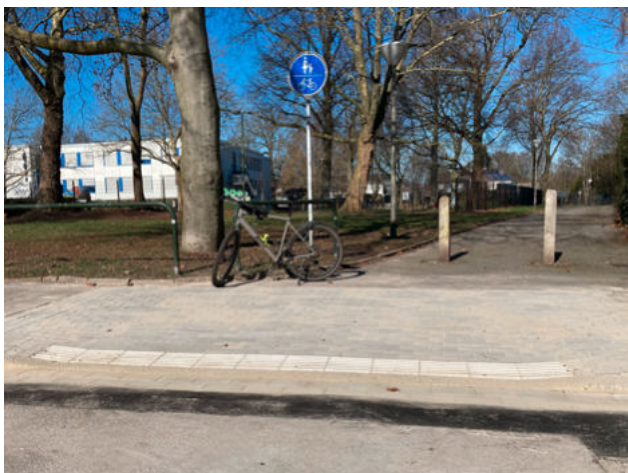
Dörwerstraße: Mit der neuen Bordabsenkung kann der Geh- und Radweg komfortabel erreicht werden.
