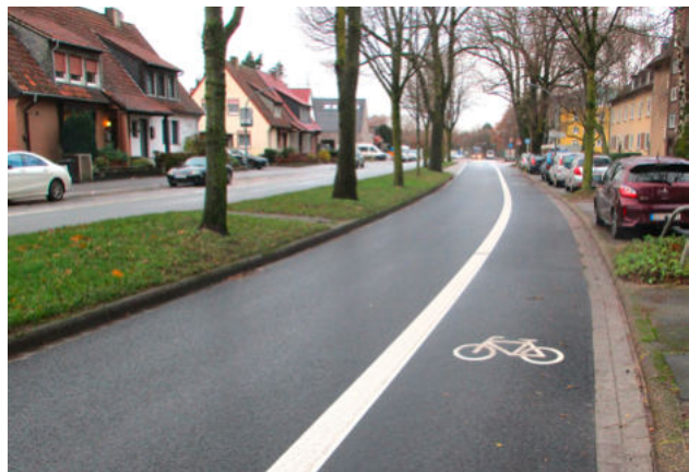
▲ Platenfeldstraße: Mit der Erneuerung des Asphalts ist der Radfahrstreifen auf zwei Meter verbreitert worden.
