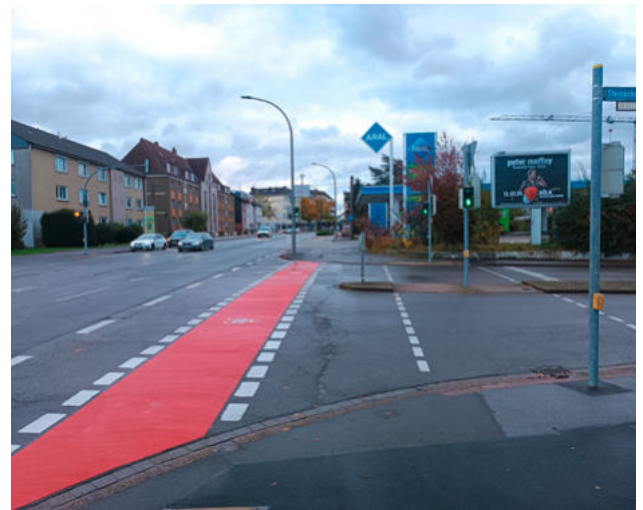
Stockumer Straße/Steinackerstraße: Die rote Furt sorgt für Aufmerksamkeit.
