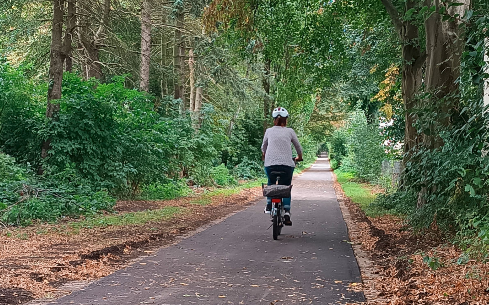
Verbindungsweg zwischen Leni-Rommel-Straße und Holzwickeder Straße: Keine Wurzelaufbrüche. Der Geh- und Radweg wurde auf einer Länge von 300 Meter neu asphaltiert.
