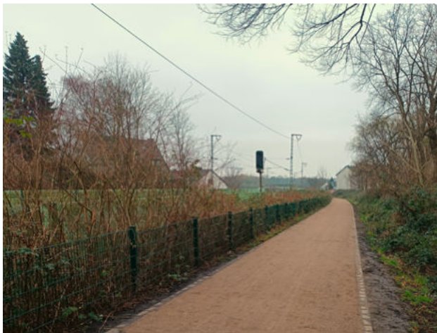
Alte Zechenbahn/Am Eckey: Der Weg ist wieder eben und in voller Breite nutzbar.
