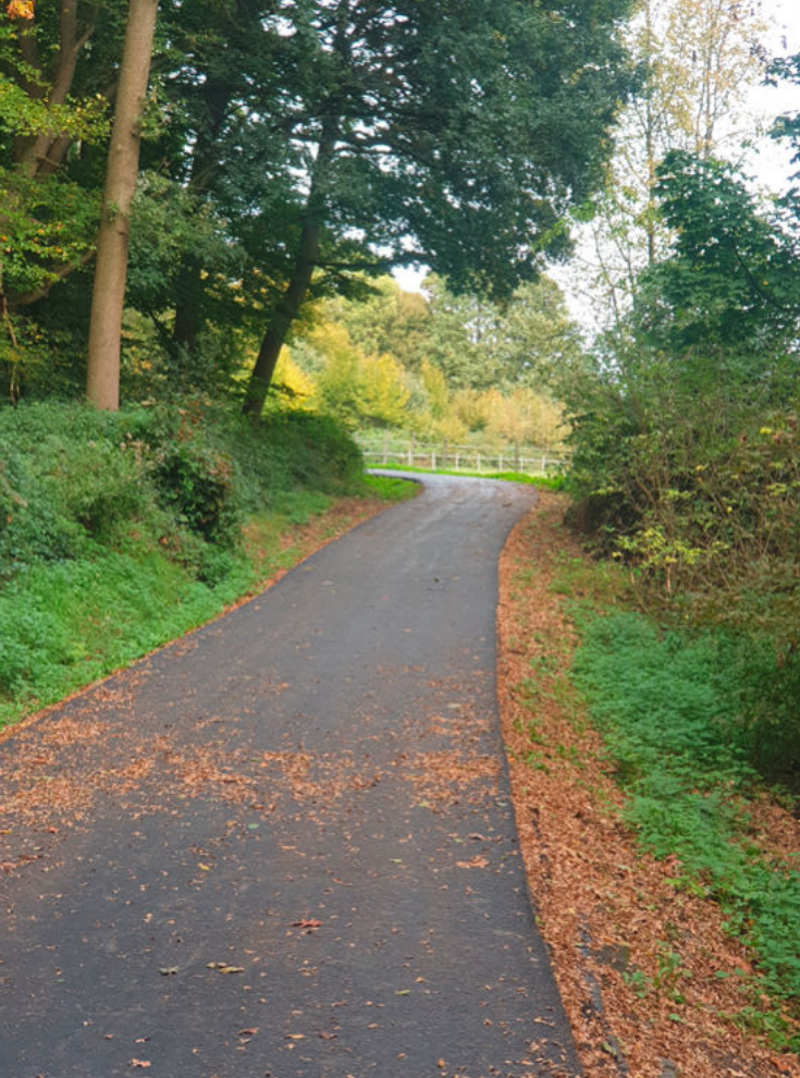
Am Liebringskamp: Auf einer Länge von 250 Meter wurde der Geh- und Radweg erneuert.
