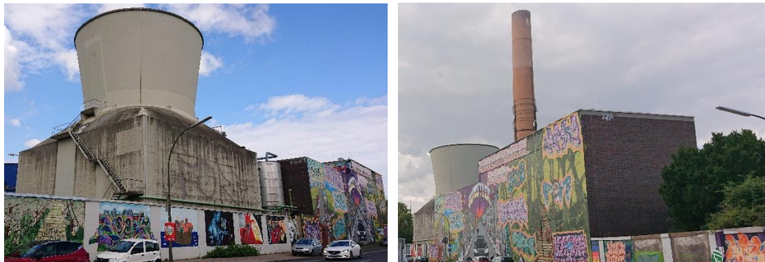
Abbildung 49: Kraftwerk „Weißburger Straße“ Quelle: eigene Darstellung, Stadt Dortmund
