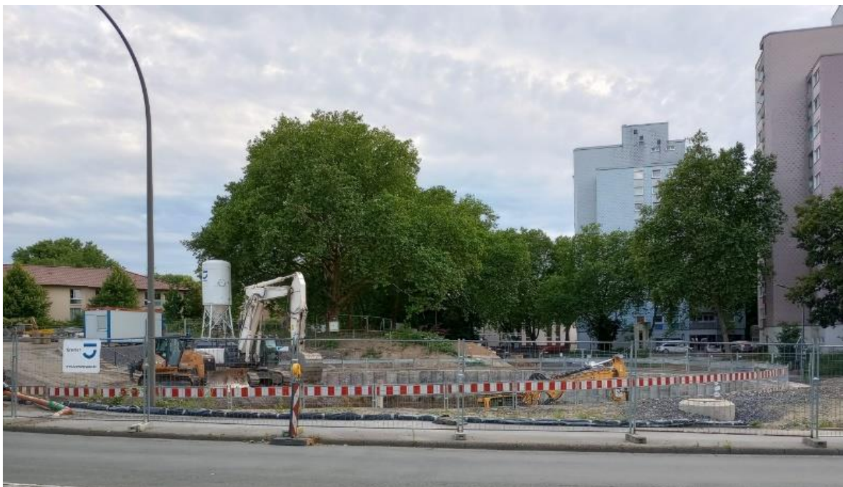
Abbildung 47: Regenrückhaltebecken am Vogelpothsweg in Bau, Juli 2022
