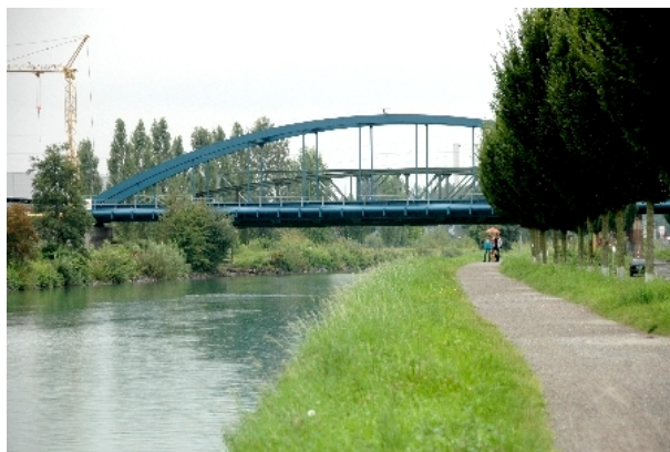
Bahnbrücke Deusen–Lindenhorst im Bau
