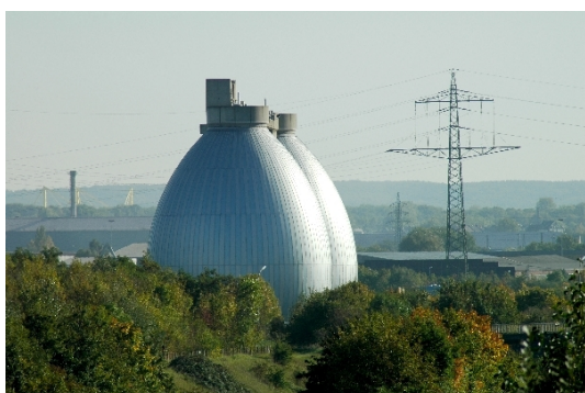
Faultürme der Kläranlage Dortmund-Nord
