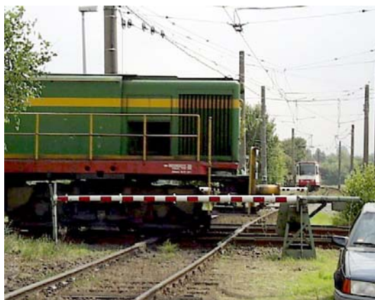
Kreuzungsbereich Stadtbahn- und DB-Güterzugstrecke
