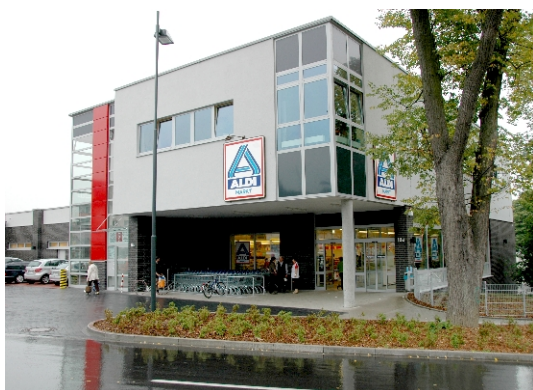
Neues Einkaufszentrum Kirchlinde
