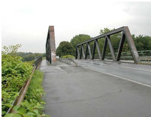
Lindenhorster Brücke (Ellinghauser Straße)
