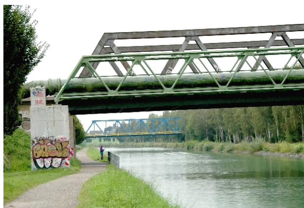
Lindenhorster Rohr- und Straßenbrücke und im Hintergrund die Bahnbrücke zum GVZ Ellinghausen
