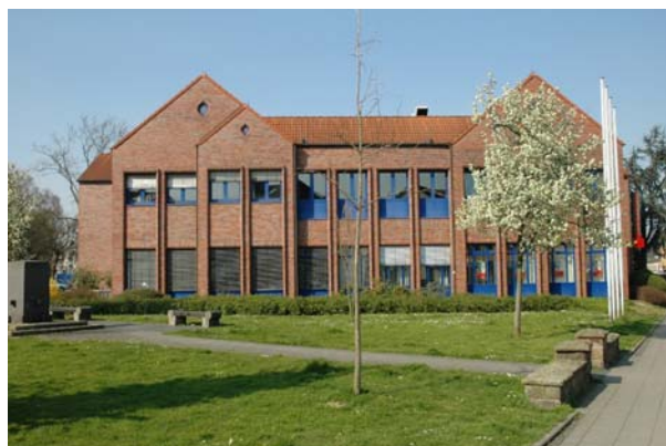
Gebäude der Bezirksverwaltungsstelle Huckarde
