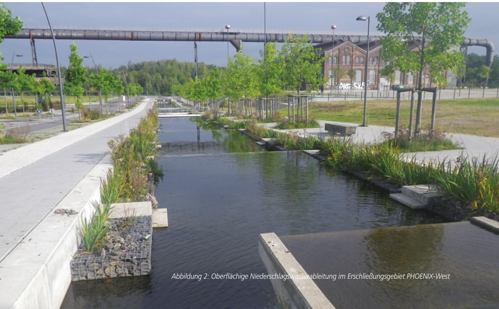
Abbildung 2: Oberflächige Niederschlagswasserableitung im Erschließungsgebiet PHOENIX-West
