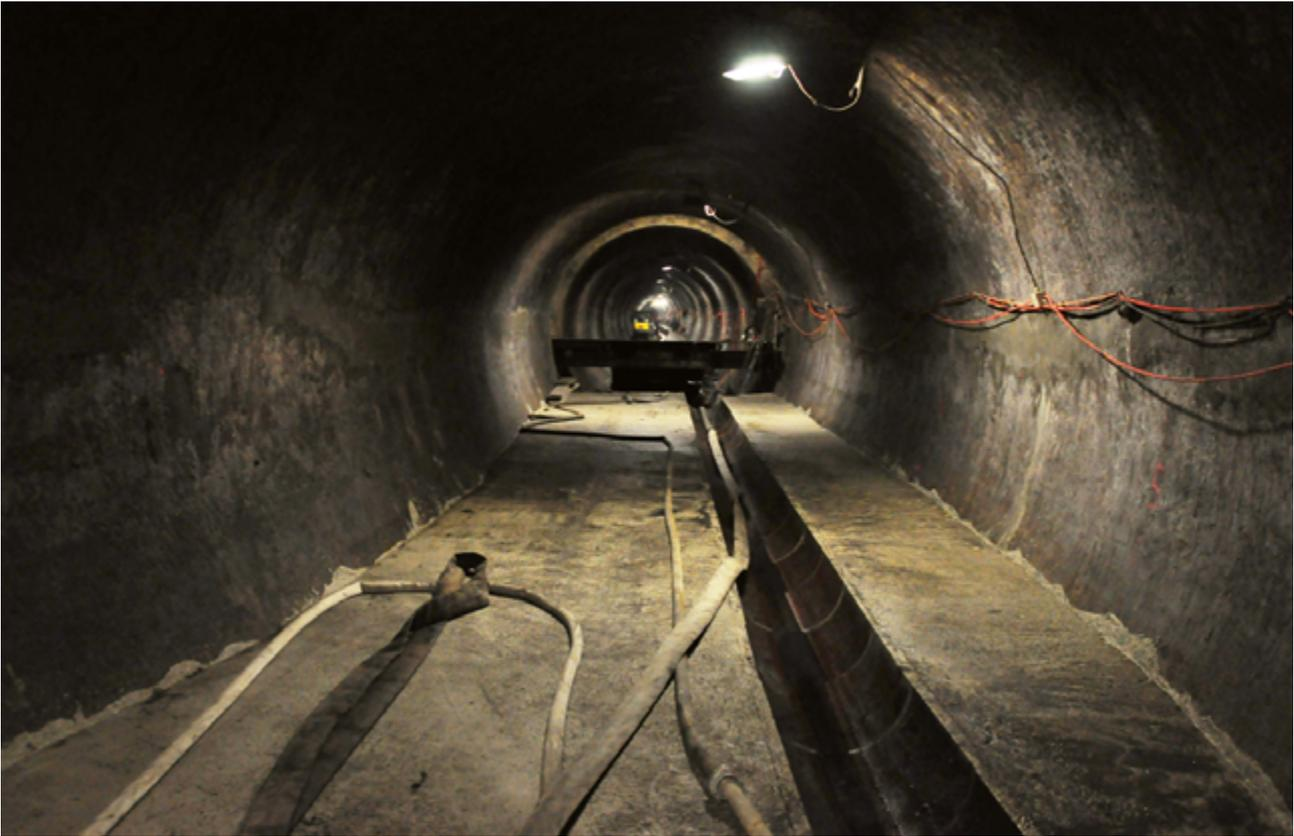
Abbildung 28: Einbau der Trockenwetterrinne
