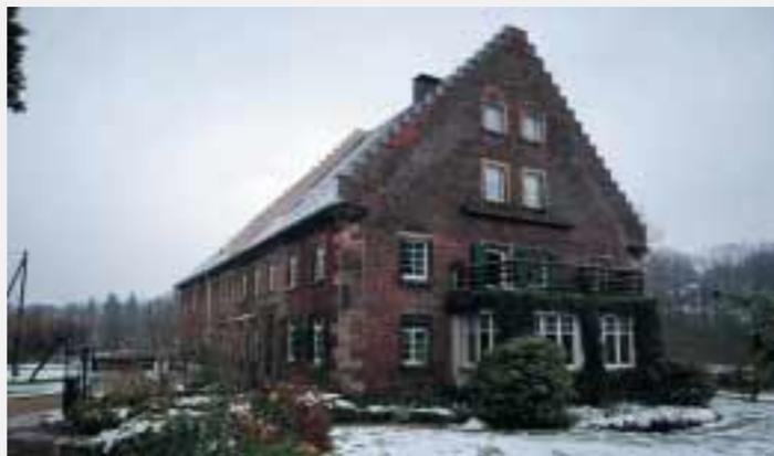
sige Wohnhaus von der repräsentativsten Seite. Der massive Backsteinbau mit seinem neugotischen Treppengiebel stammt vermutlich aus dem Jahre 1849. Natursteinquadern betonen die Gebäudeecken. 1911 wurde am Wohngiebel ein eingeschossiger Erker mit Balkon angebaut.
