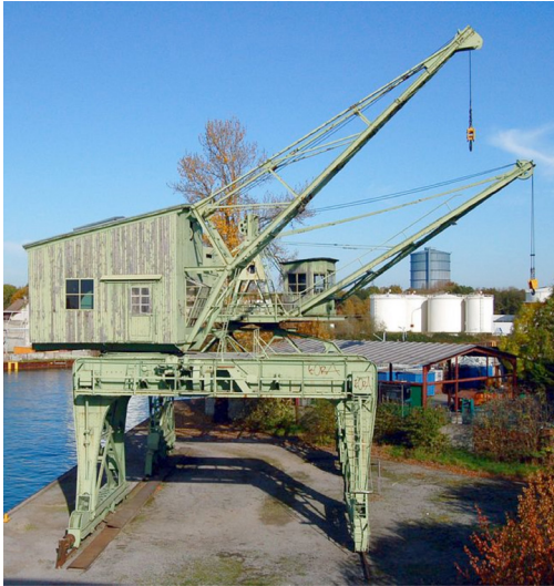
Portaldrehkran Franziusstraße, DO
