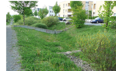
Beispielbild Regenrückhalteelementen mit seitlichem Baumbestand
