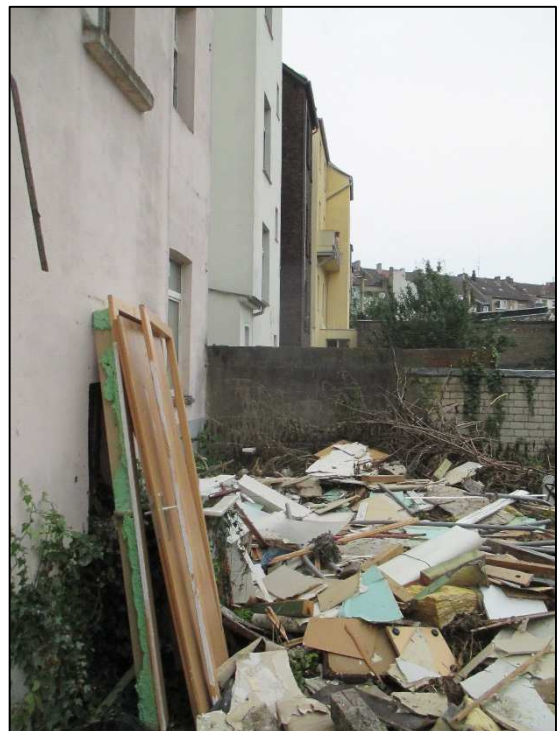
Problemimmobilie, Lortzingstraße Foto: Stadt Dortmund, Amt für Wohnen und Stadterneuerung
