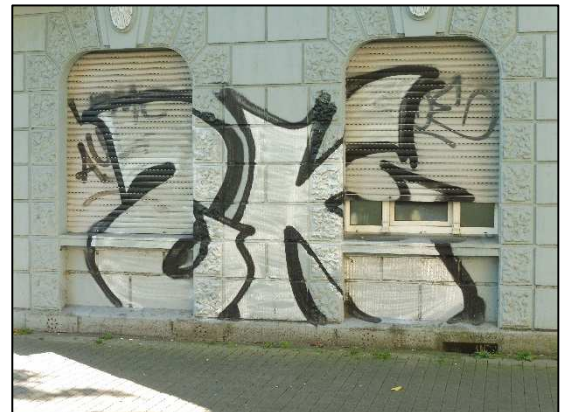
Brunnenstraße Foto: Stadt Dortmund, Amt für Wohnen und Stadterneuerung
