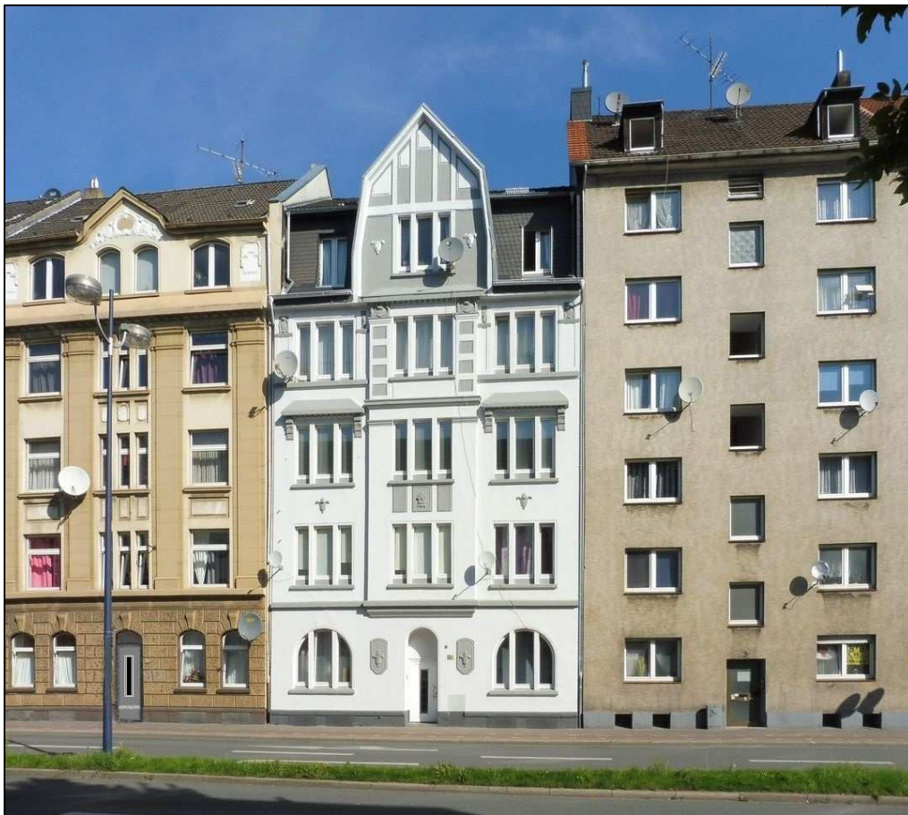
Mallinckrodtstraße, geförderte Fassadenaufwertung Foto: Stadt Dortmund, Amt für Wohnen und Stadterneuerung
