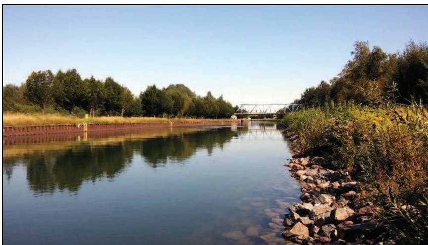
Dortmund-Ems-Kanal, Höhe Ellinghauser Straße; Foto: Stadt Dortmund, Amt für Wohnen und Stadterneuerung
