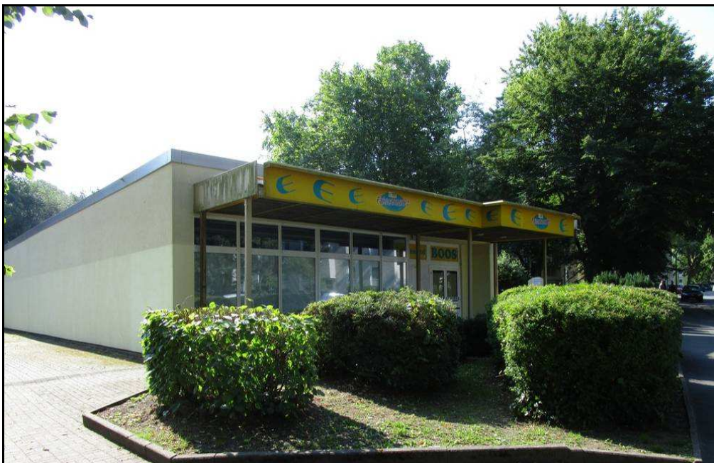
Echeloh 51, leer stehendes Ladenlokal; Foto: Stadt Dortmund, Amt für Wohnen und Stadterneuerung
