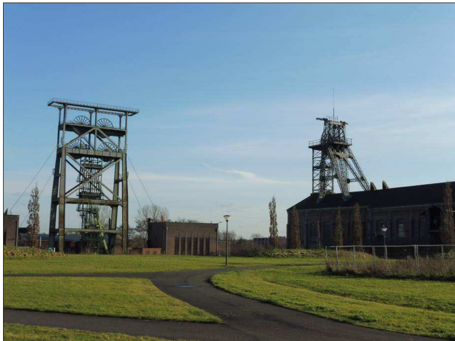
Quelle: Eigenes Foto, Doppelbock-Fördergerüst und Tomson-Bock
