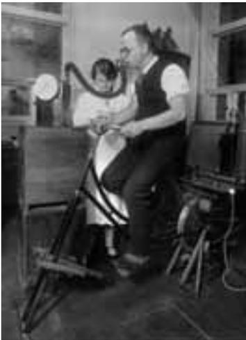
Ergometer mit Respirationsapparat
