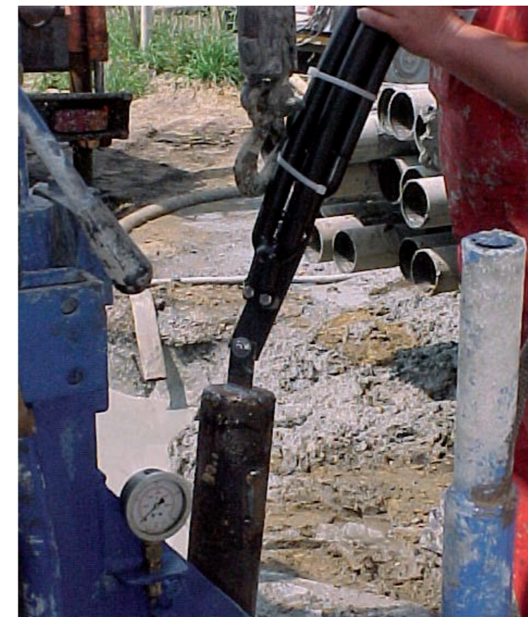
[Bild 32] Sondenfuß mit Gewicht
