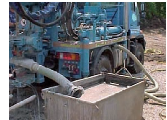
[Bild 28] Bohrfahrzeug mit Auffangbehälter
