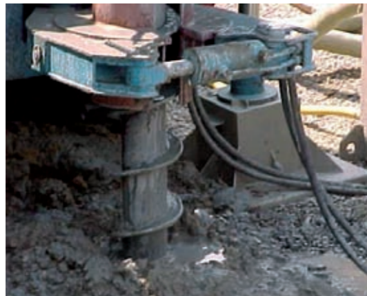
[Bild 25] Bohrfahrzeug während einer Bohrung
