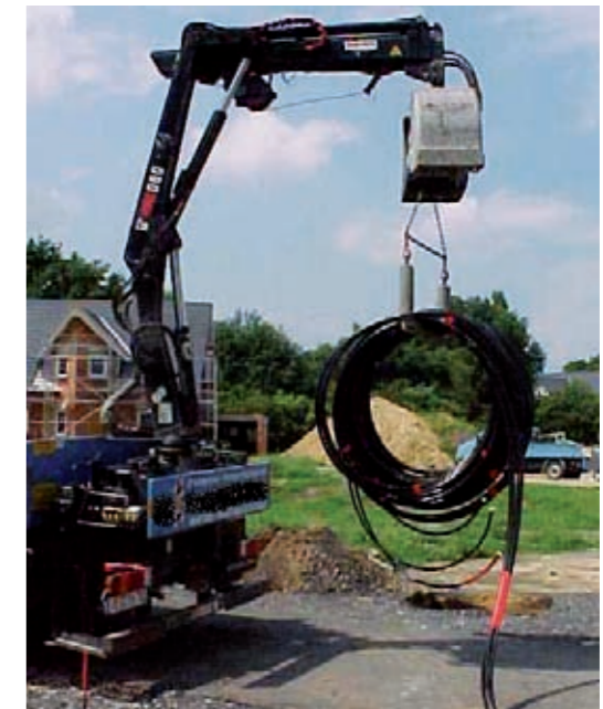
[Bild 13] Sondenrohr vor dem Einbau
