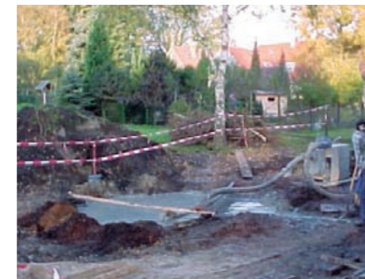
[Bild 27] Bohrschlamm einleitung in Mulde
