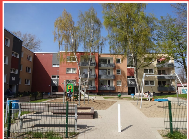
Freifläche Kiepeweg 6-10b nach der Sanierung
