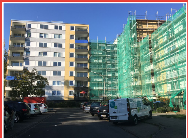
Gerlachweg 5-7 während der Sanierung
