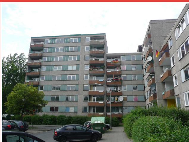
Gerlachweg 5-7 vor der Sanierung
