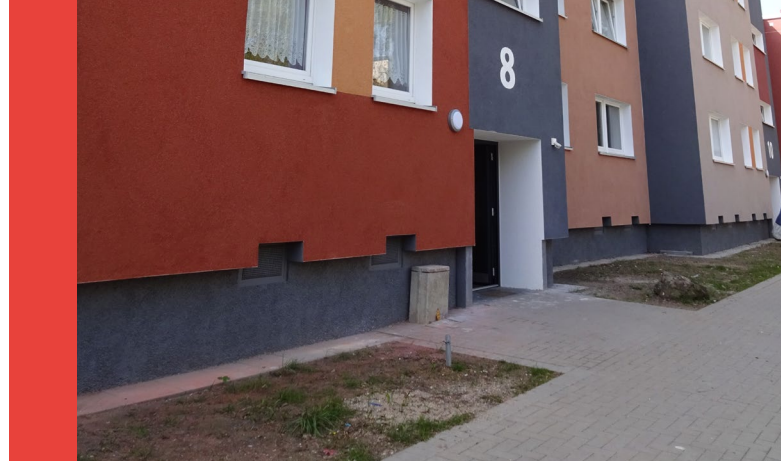
Neugestalteter, barrierefreier Hauseingang im Kiepeweg
