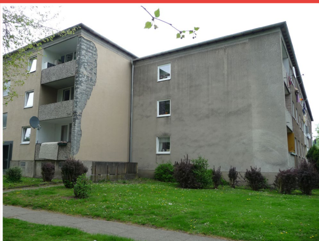
Kiepeweg 22 vor der Sanierung
